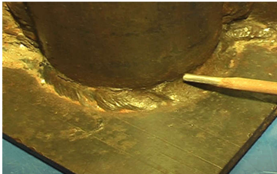
Рисунок 3 – Дефект зварного шва (підріз)
