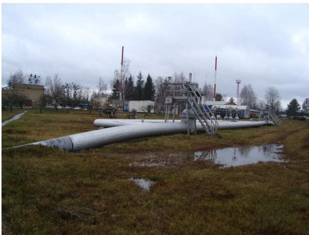
Рисунок 6 – Вигляд затопленої водою досліджуваної ділянки НПС з наявними підземними нафтопроводами на ній
