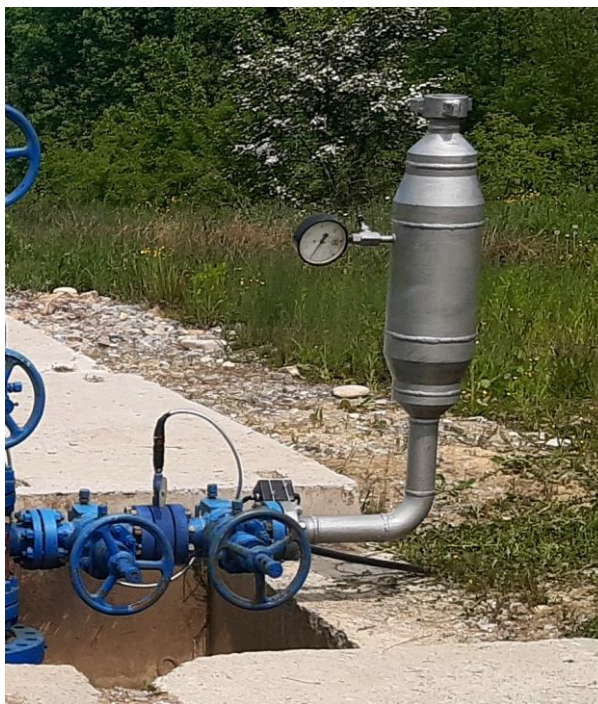
Рисунок 8 – Варіант підключення АСП при подаванні ПАР у затрубний простір свердловини
