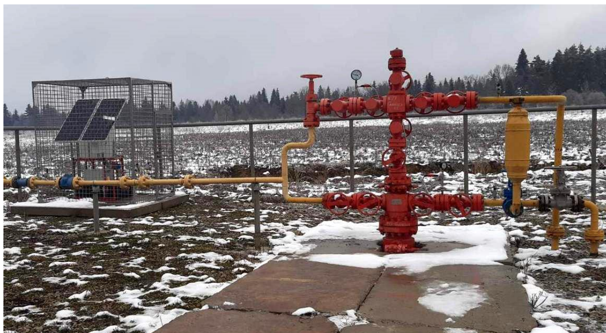
Рисунок 5 – Загальний вигляд АСП та фонтанної арматури свердловини
