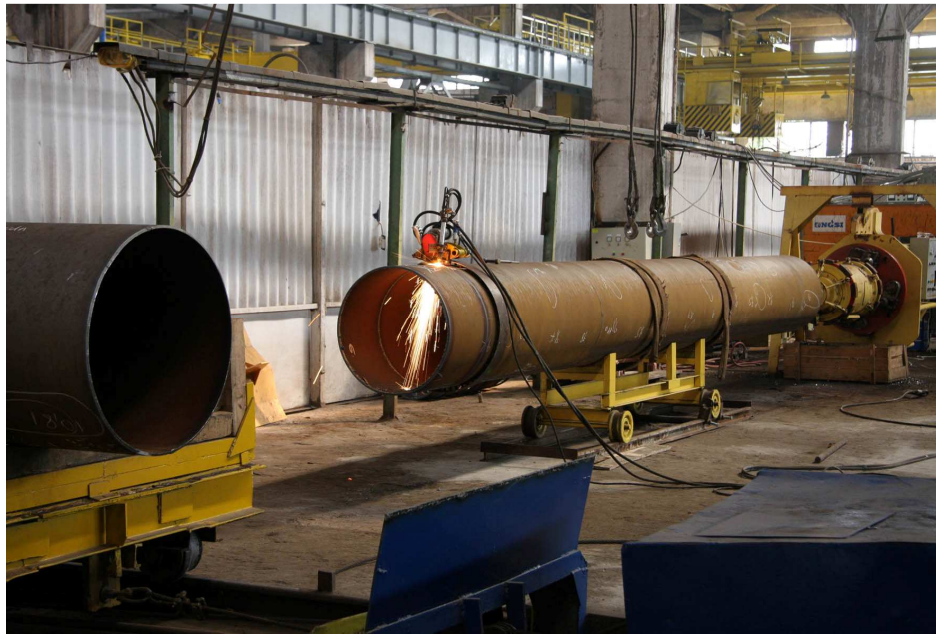
Рисунок 12 – Ремонт тіла труби на заводі
