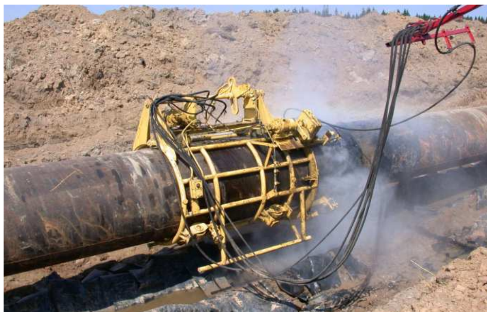
Рисунок 4 – Універсальна самохідна машина. Видалення старої ізоляції [2]
