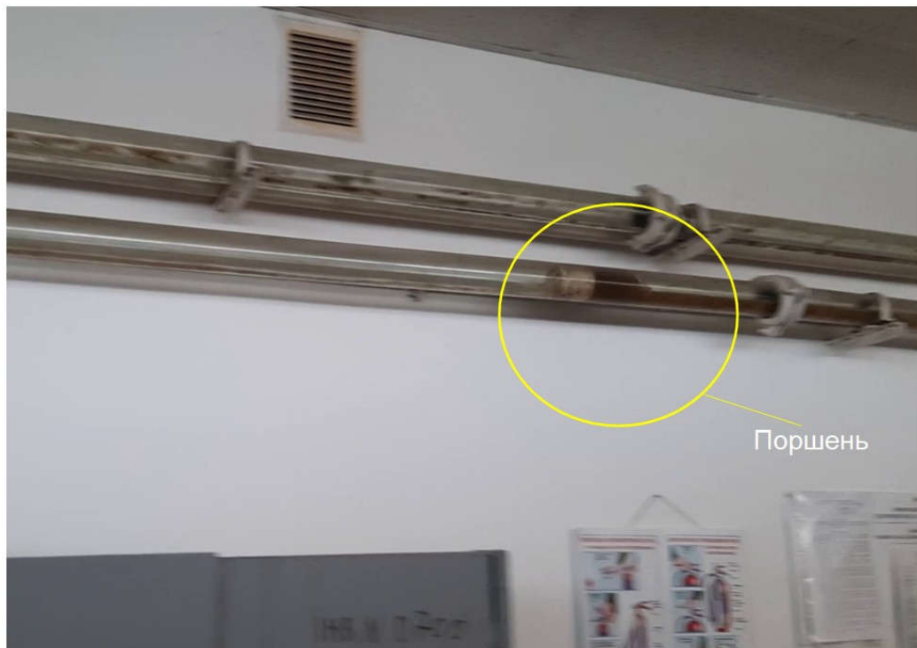
Рисунок 10 – Очищення горизонтальної прямолінійної ділянки трубопроводу поршнем із гіперпружного матеріалу, який рухається із постійною швидкістю 3,2 м/с
