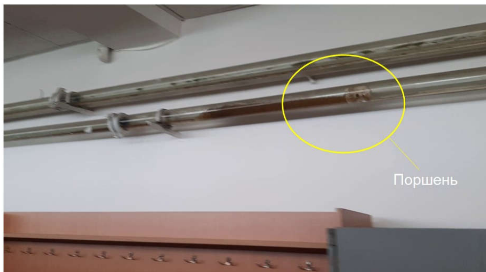
Рисунок 11 – Очищення горизонтальної прямолінійної ділянки трубопроводу поршнем із гіперпружного матеріалу, який рухається із постійною швидкістю 0,8 м/с
