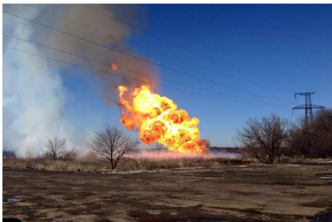
Рисунок 2 – Пожежа на ділянці газопроводу “Новопсков – Краматорськ” 17.02.15 р.
