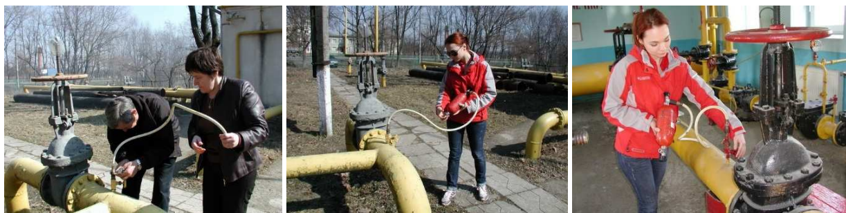
Рисунок 3 – Процес відбору проб природного газу для проведення досліджень на об'єктах ПАТ «Івано-Франківськгаз»
