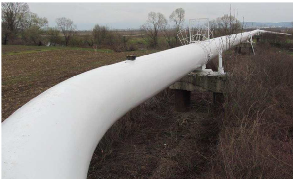
Рисунок 6 – Наземна ділянка лінійної частини магістрального газопроводу з виявленим макророзшаруванням
