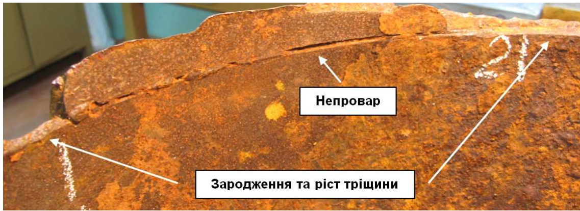
Рисунок 2 – Приклад зародження та поширення тріщини від концентратора напружень, спричиненого непроваром у кільцевому зварному шві газопроводу
