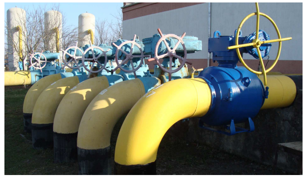
Рисунок 1 – Серія відвідних від КС труб газотранспортної системи
