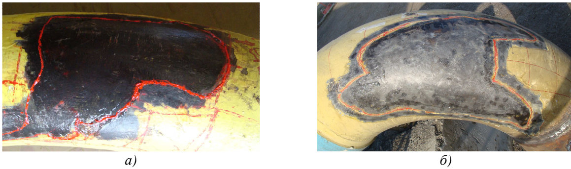
Рисунок 2 – Окреслене контуром розширення у стінці колін відвідних від КС труб А (а) та Б (б) газотранспортної системи
