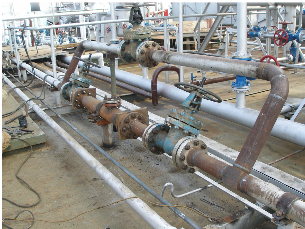
Рисунок 5 – Фотозображення врізу в дослідну лінію газового промислу МСП-17 блоку первинних перетворювачів вимірювальної ділянки пристрою контролю структури потоку
