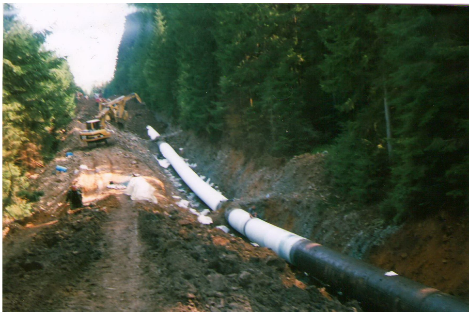
Рисунок 2 — Ремонт трубопроводу за допомогою композитних підсилюючих бандажів фірми «Поліпромсинтез»
